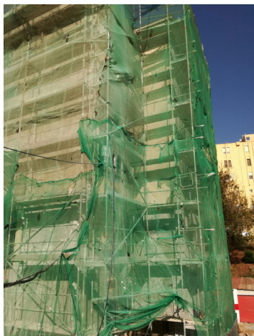
Bloque de pisos de la barriada de Los Rosales, rodeados de andamios en la época de reproducción del Avión común Foto: Miguel A. Guirado Cajal.
