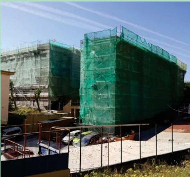
Bloque de pisos de la barriada de Los Rosales, rodeados de andamios en la época de reproducción del Avión común Foto: Miguel A. Guirado Cajal.
